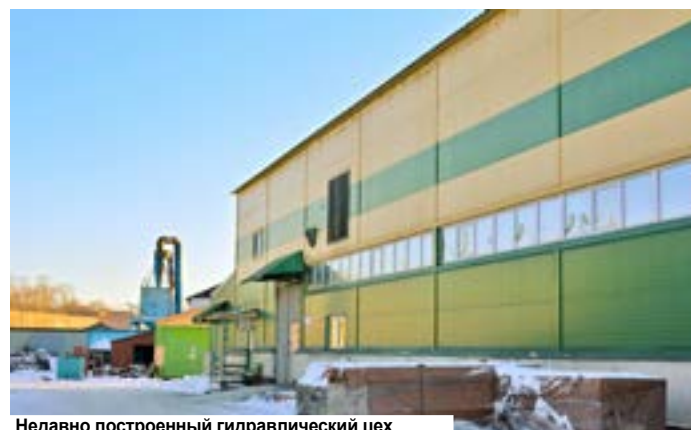
Недавно построенный гидравлический цех
